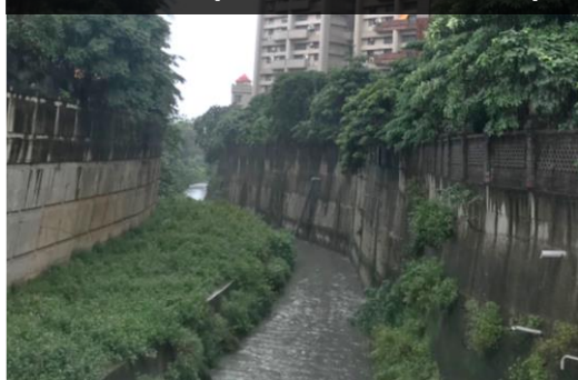
現況照片(中正公園加蓋段)
