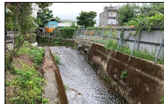
大溪國中上游混凝土斜坡
