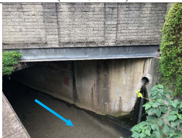
④春日路下游側；雙孔箱涵出口 (WxH=3.0x3.0m)
