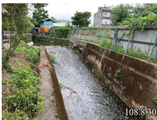
街口溪大溪國中上游混凝土斜坡
