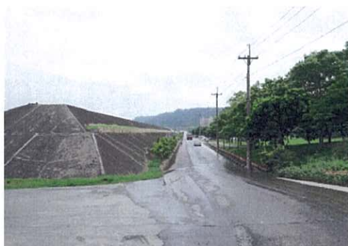
(4) 缺子堤防缺口
