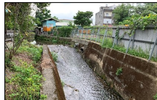
大溪國中上游混凝土斜坡
