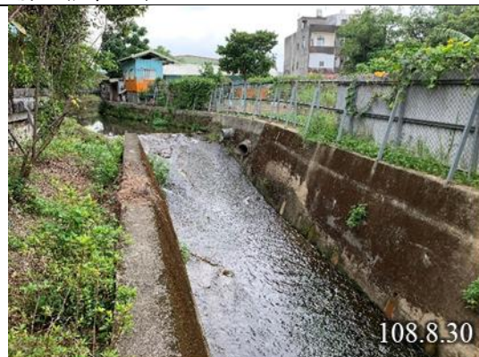
街口溪大溪國中上游混凝土斜坡
