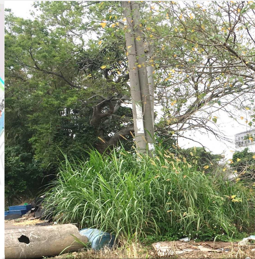
電線桿為台電所有
