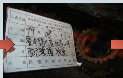
污水管線及 設施埋設
