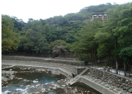
108.10.25 義盛污水處理廠廠預定地
