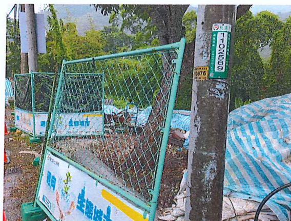
羅浮污水處理廠：
