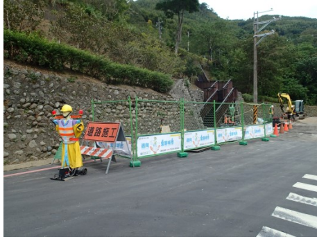
108.10.25 污水下水道施工中
