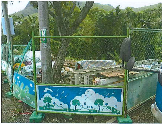
羅浮污水處理廠：
