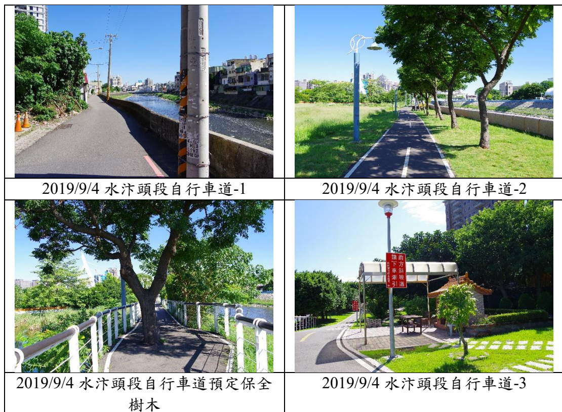
圖七、水汴頭段工程預定位置環境照
