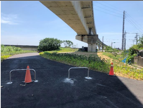
110/07/26/山腳橋旁橋頭街橋下植生空間
