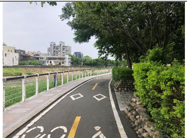
110/08/05/第一河濱公園車道
