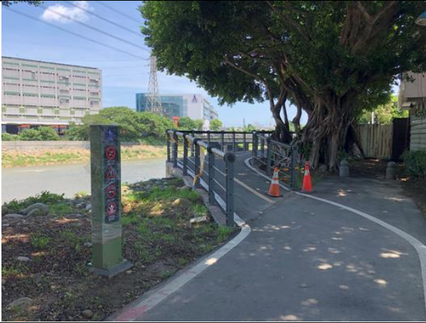
110/07/26/南崁溪橋車道出入口
