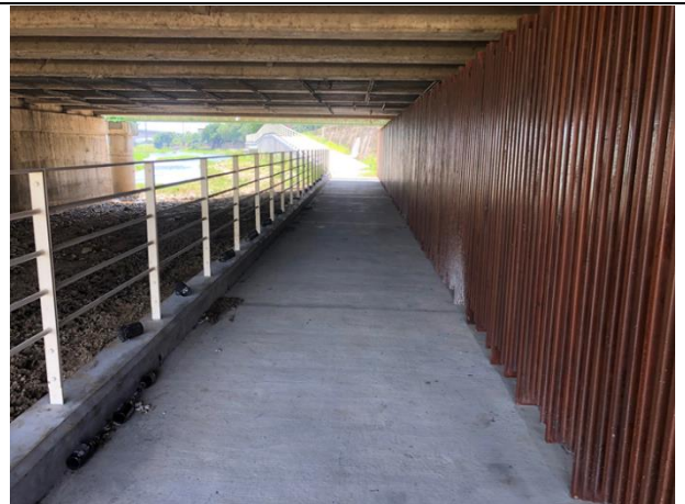
110/07/26/山鼻橋下橋下空間
