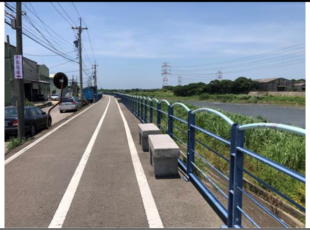
110/07/26/西溪路堤岸車道
