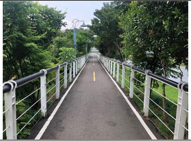
110/07/28/南平公園車道
