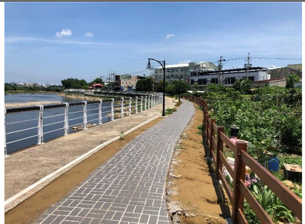
110/07/26/錦興活動中心菜園旁新設車道
