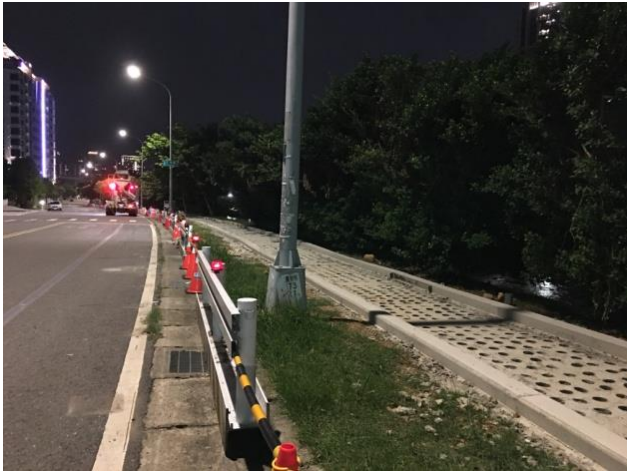
1-2 樣區-人行道施工中
