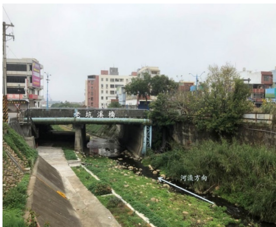
3.老坑溪橋上游處
