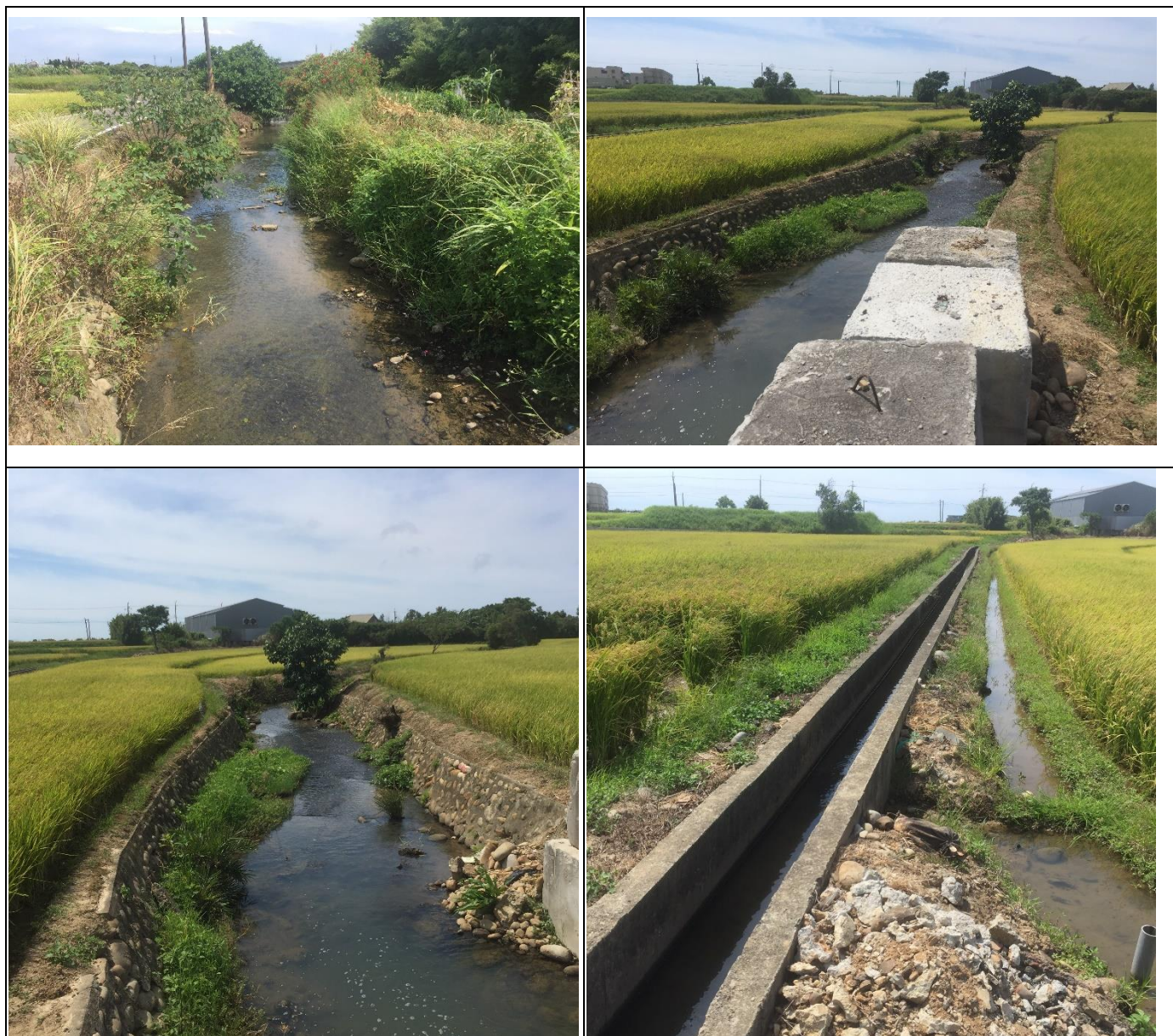
施工範圍為：藍埔里觀音橋斷面 78 至 86-1
