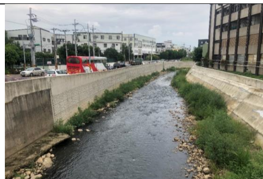
完工後現勘，右岸大樹已遭清除
