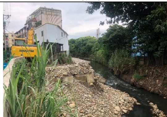
工區現場仍存在機具與施工便道路
