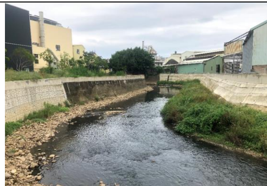
完工後現勘，右岸大樹已遭清除
