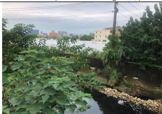
水質不良，混濁有泡沫
