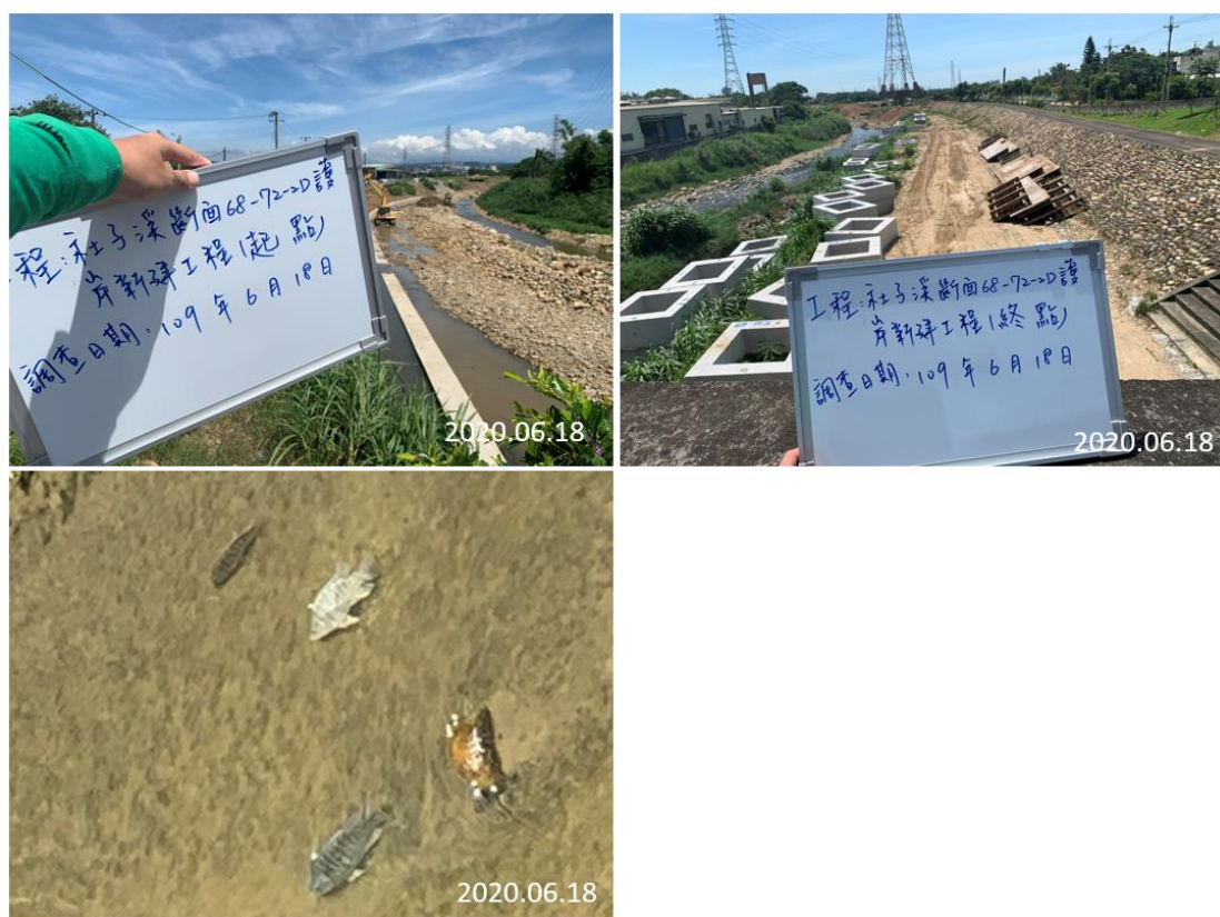
圖 4-4-49 社子溪斷面 68-斷面 72-2D 護岸新建工程(工程段)- 環境現況及水域物種照片
