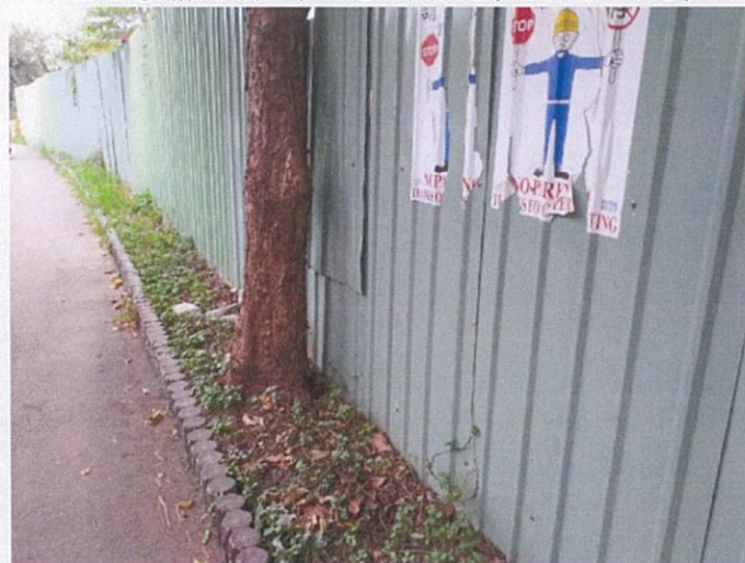
5.工區西南側貼近新莊子溪，且周圍樹木及草皮較多，人為干擾較低，較有機會出現生物(兩生、爬蟲)，該側圍籬皆貼地，可有效阻擋生物進入工區。
