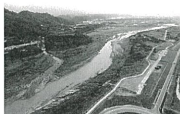
5. 跨大漢溪聯絡中庄調整池及山豬湖生態園區計畫橋址現況
