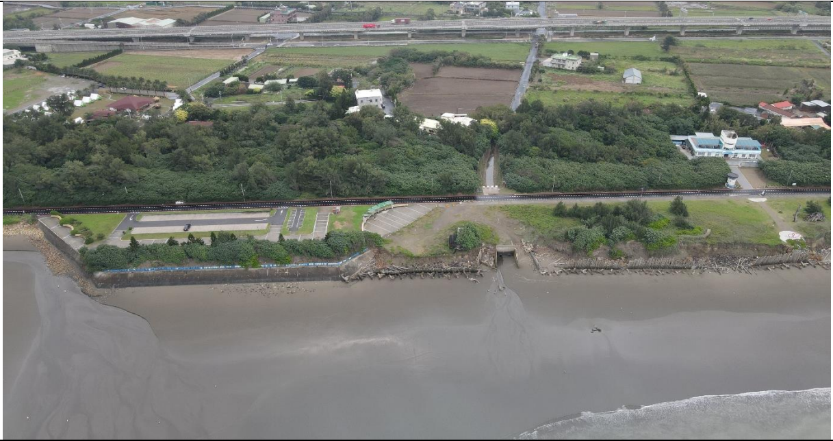
笨港海堤北側
