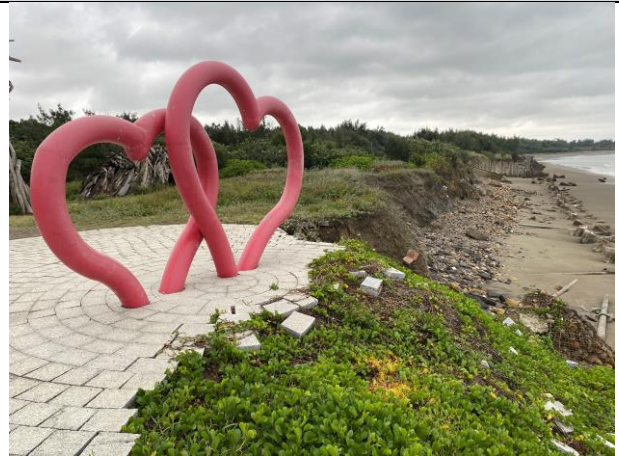
好客莊園前邊坡崩落
