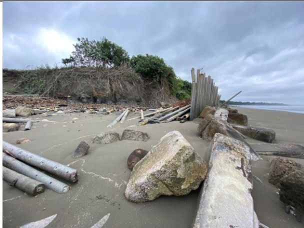
廢棄電線杆倒塌
