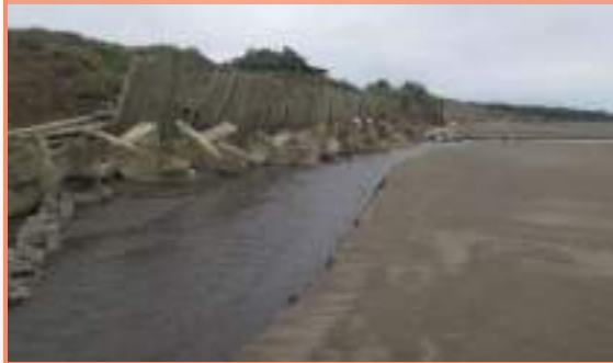
拔除電線桿、做成緩坡搭配養灘
