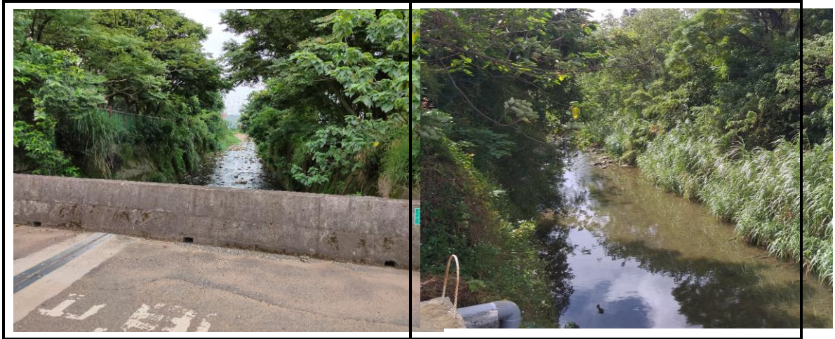
施工範圍為：大堀溪斷面 84-2 至斷面 85 左岸護岸現勘照片
