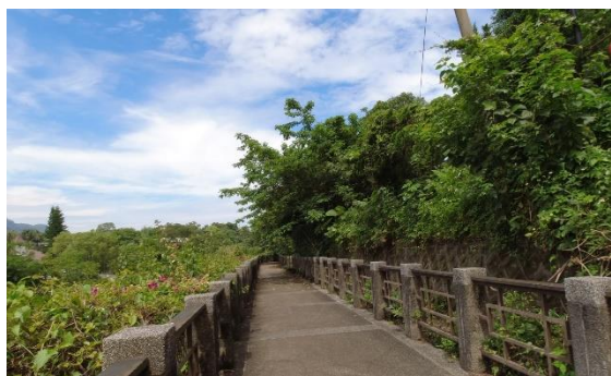
111.05.12/工區上游步道現況
