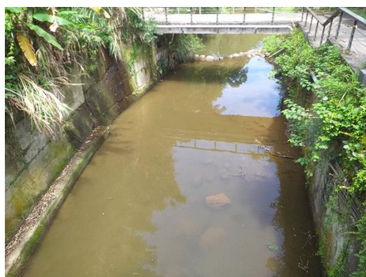
111.05.12/工區下游緩流區
