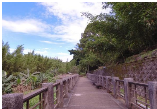
111.05.12/工區中游步道現況
