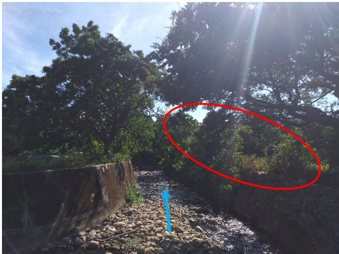
3. 右岸噴凝土補強護岸，建議可保留堤頂及堤內植被。
