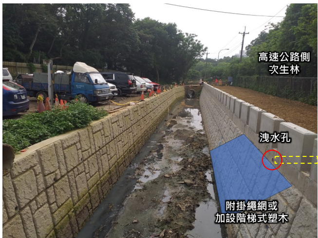
附掛繩網或加設階梯式塑木，以此連接渠底及洩水孔
