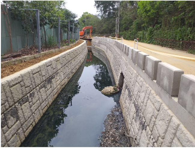
工程渠道現況
