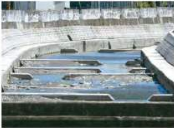
水利署長陳明水昨日在東大溪水溝整治工程現場視察。圖：水利署提供
