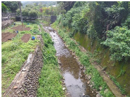
111.05.12/工區中遊河道護岸及農田
